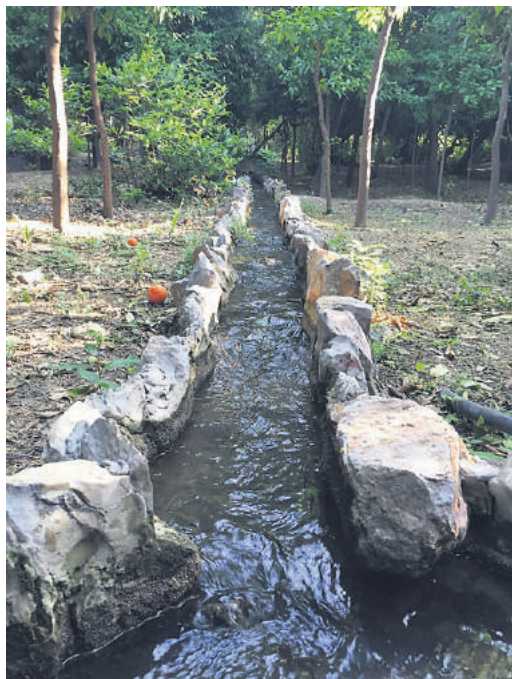
Καθαρό κανάλι με νερό
